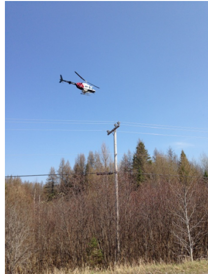
Photo 1. Application par voie aérienne (Bell 206)
